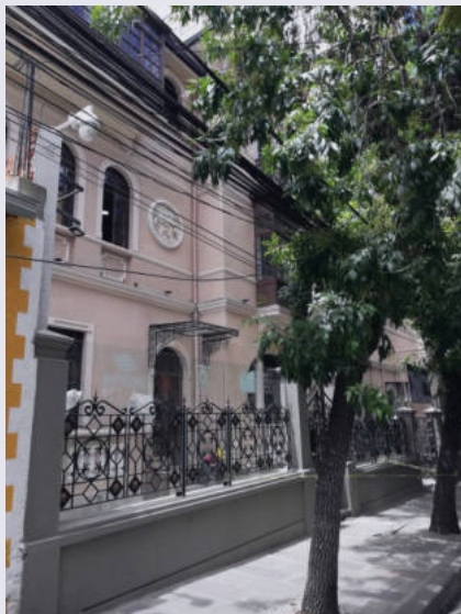
Fachada restaurada, izq. Ficha de daños, derecha.
